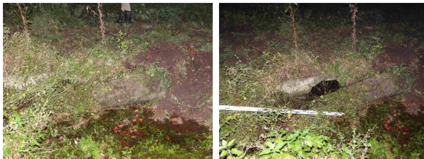
FOT. 27 OBIEKT NR 732.5.11 – ISTNIEJĄCY PRZEPUST W LEŚNICTWIE UJEŹDZIEC, ODDZIAŁ 253C; A) WLOT PRZEPUSTU, B) WYLOT PRZEPUSTU
