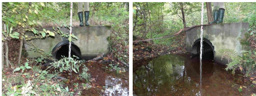
FOT. 26 OBIEKT NR 732.5.6A – ISTNIEJĄCY PRZEPUST W LEŚNICTWIE UJEŹDZIEC, ODDZIAŁ 256B; A) WLOT PRZEPUSTU, B) KONSTRUKCJA PRZEPUSTU
