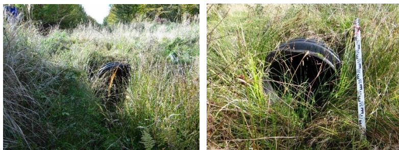
FOT. 30 OBIEKT NR 732.5.24 – ISTNIEJĄCY PRZEPUST W LEŚNICTWIE UJEŹDZIEC, ODDZIAŁ 223C; A) WLOT PRZEPUSTU, B) WYLOT PRZEPUSTU
