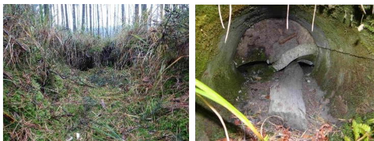
FOT. 21 OBIEKT NR 732.4.16 – ISTNIEJĄCY PRZEPUST W LEŚNICTWIE GRUSZECZKA, ODDZIAŁ 195A; A) WŁOT PRZEPUSTU, B) ŚWIATŁO PRZEPUSTU
