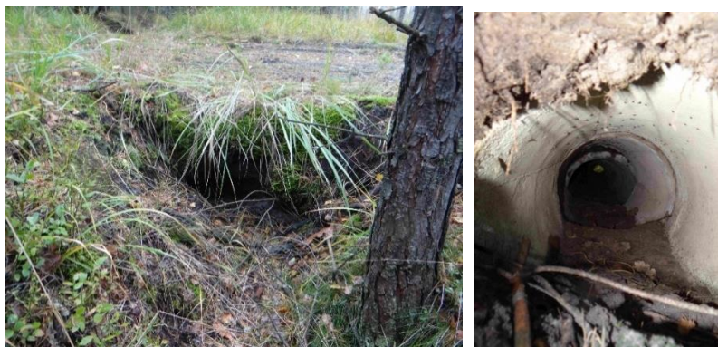
FOT. 15 OBIEKT NR 732.4.10 – ISTNIEJĄCY PRZEPUST W LEŚNICTWIE GRUSZECZKA, ODDZIAŁ 200A; A) WLOT PRZEPUSTU, B) ŚWIATŁO PRZEPUSTU
