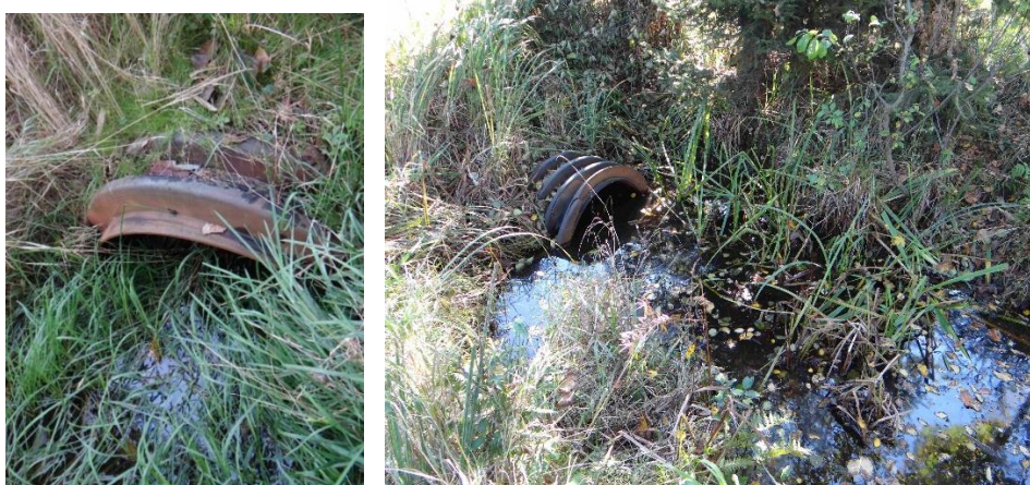
FOT. 11 OBIEKT NR 732.2.16 – ISTNIEJĄCY PRZEPUST W LEŚNICTWIE ŁĄKI, ODDZIAŁ 129A; A) WLOT PRZEPUSTU, B) WYLOT PRZEPUSTU
