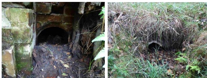
FOT. 10 OBIEKT NR 732.1.20 – ISTNIEJĄCY PRZEPUST W LEŚNICTWIE OLSZA, ODDZIAŁ 33J; A) WŁOT PRZEPUSTU, B) WYŁOT PRZEPUSTU
