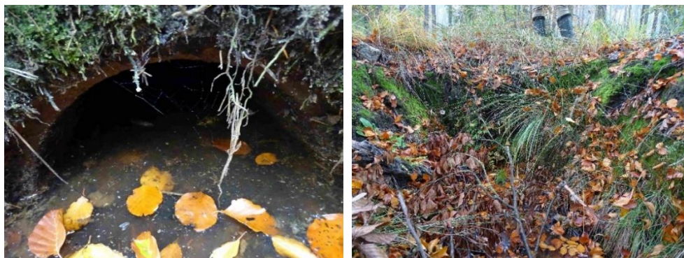
FOT. 9 OBIEKT NR 732.1.19 – ISTNIEJĄCY PRZEPUST W LEŚNICTWIE OLSZA, ODDZIAŁ 32F; A) WŁOT PRZEPUSTU, B) WYŁOT PRZEPUSTU
