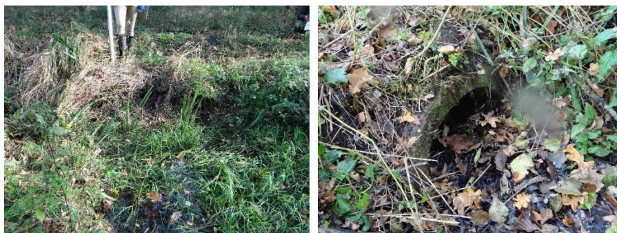
FOT. 7 OBIEKT NR 732.2.35 – ISTNIEJĄCY PRZEPUST W LEŚNICTWIE ŁĄKI, ODDZIAŁ 61J; A) WLOT PRZEPUSTU, B) WYLOT PRZEPUSTU
