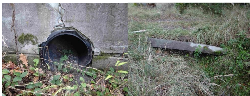
FOT. 11 OBIEKT NR 732.4.1 – ISTNIEJĄCY PRZEPUST W LEŚNICTWIE GRUSZECZKA, ODDZIAŁ 113G; A) WLOT PRZEPUSTU, B) WYLOT PRZEPUSTU
