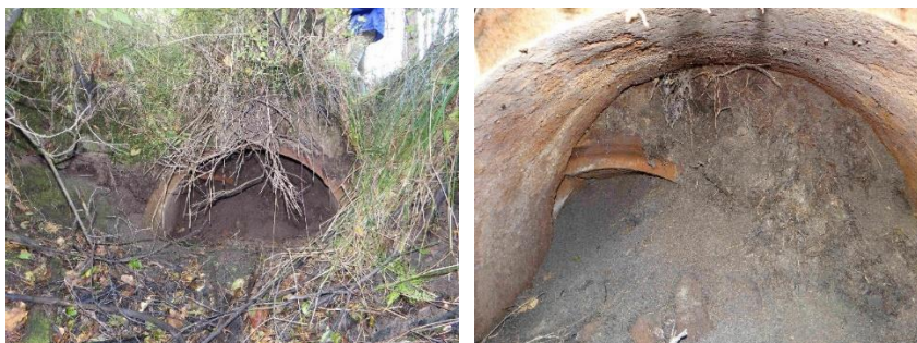
FOT. 10 OBIEKT NR 732.3.28 – ISTNIEJĄCY PRZEPUST W LEŚNICTWIE KONIOWO, ODDZIAŁ 202F; A) WLOT PRZEPUSTU, B) ŚWIATŁO PRZEPUSTU
